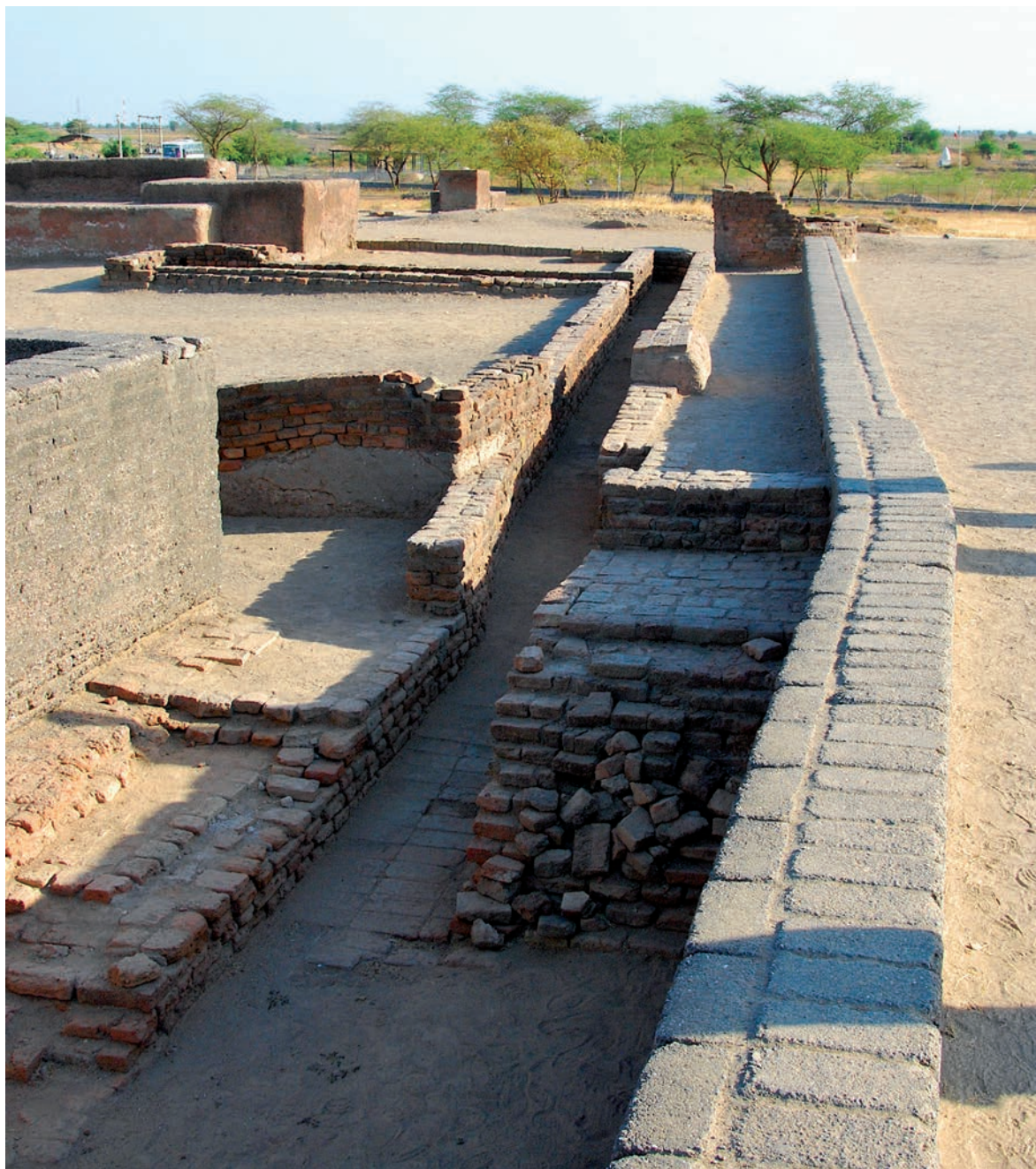
चित्र 6.7 — लोथल (गुजरात) में जल-निकास प्रणाली
